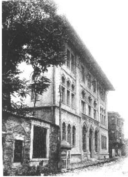
Medresetü'l- Kuzzat Binası'nda İstanbul Üniversitesi Merkez Kütüphanesi
